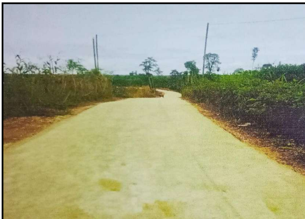
Dokumentasi Lanjutan Pengaspalan Jalan Jrs Jalan SMP N 2 Tj. Beringin-Dolok Tolong, link. 384 Kec. Sumbul (Pembangunan Jalan)
