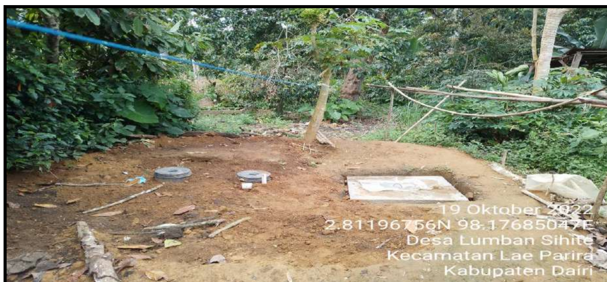
Dokumentasi Pemasangan Tangki Septik Desa Lumban Sihite Kecamatan Lae Parira
