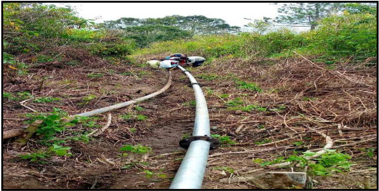
Dokumentasi Pemasangan Pipa GIP Pengembangan Jaringan Distribusi dan Sambungan Rumah (SR) di Desa Paropo I, Kec. Silahisabungan.
