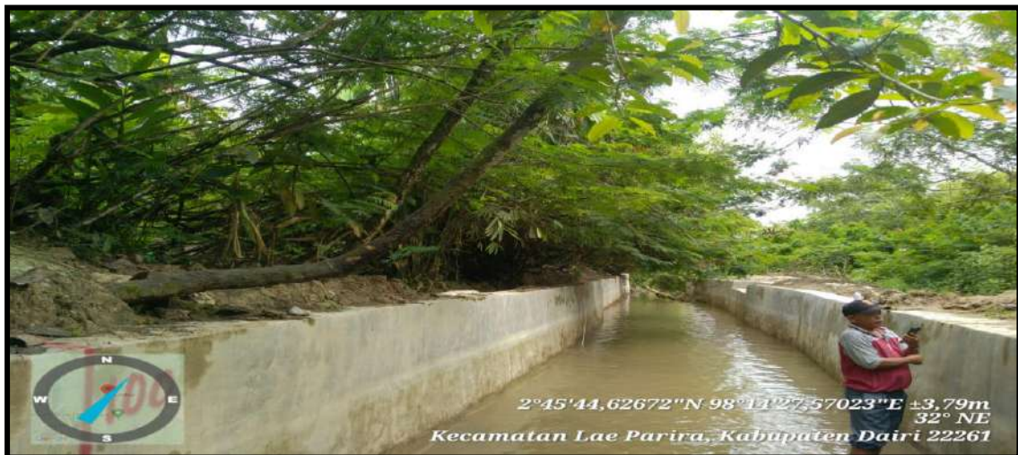
Dokumentasi Rehabilitasi Jaringan Irigasi D.I. Gabelas Kecamatan Lae Parira
