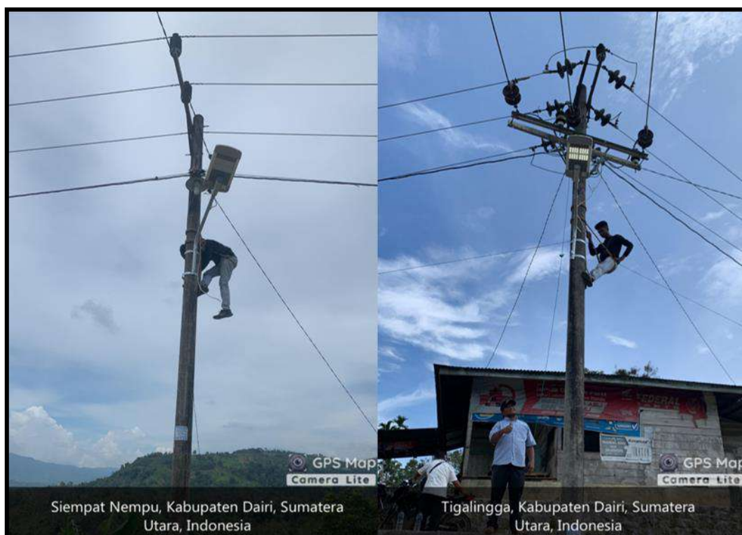
Dokumentasi Pemasangan Penerangan Jalan Umum (PJU)
