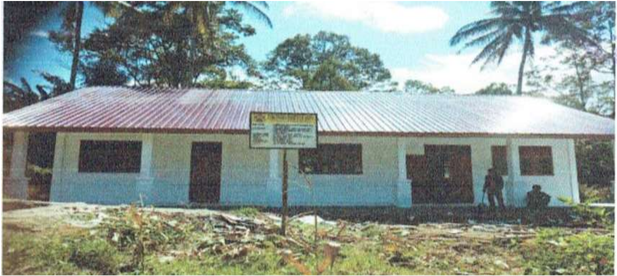
Pembangunan Perpustakaan SMP
